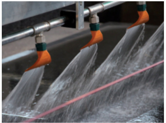
Steinabwasch-Anlage Stone washing unit
